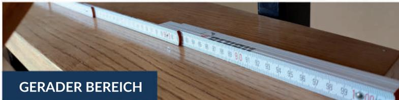
Legen Sie den Zollstock auf die schmalste Stufe im geraden Bereich der Treppe. Den Handlauf binden Sie bitte nicht in die Messung ein.
