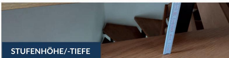
Suchen Sie die Stelle mit der geringsten Stufenhöhe und -tiefe. Messen Sie nun die Stufenhöhe und -breite in einem Abstand von ca. 20 cm zur Wand bzw. zum Geländer.
