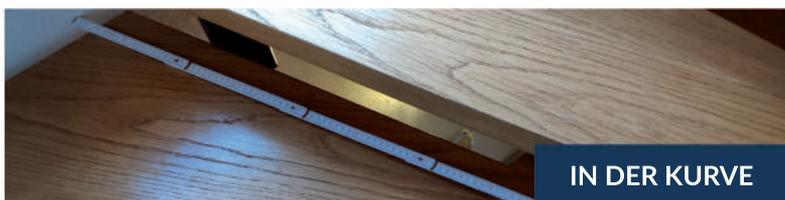
Nur bei kurvigen Treppen: Messen Sie die schmalste Stufe in der Kurve. Den Handlauf ziehen Sie wieder ab.
